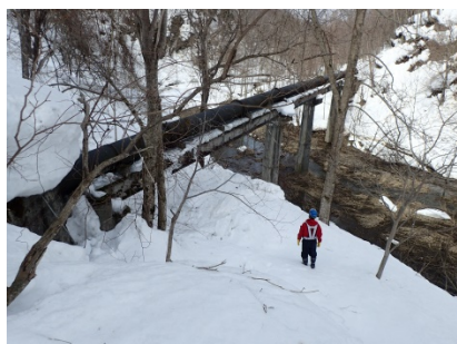
管路点検の様子
